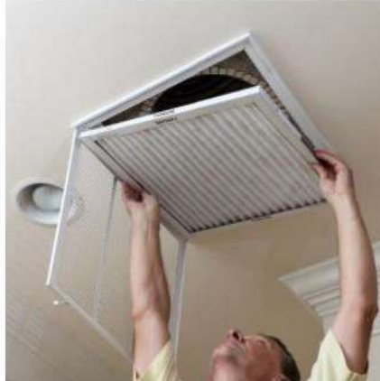
CAMBIO Y MANTENIMIENTO DE FILTROS
