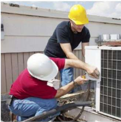
MANTENIMIENTO DE EQUIPOS Y SISTEMAS DE FILTRACIÓN
